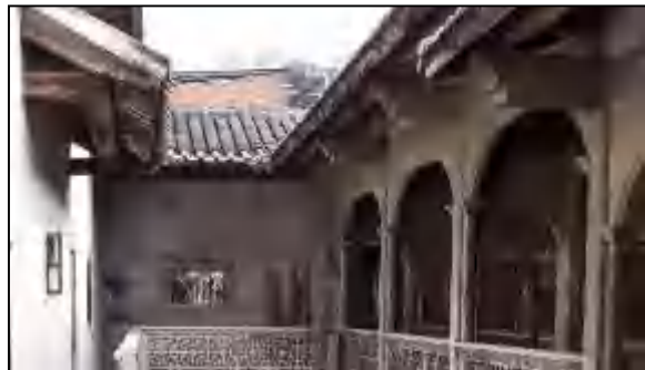
东侧横屋上的石构件支撑檐檩
