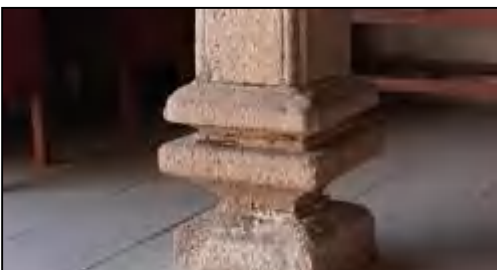
堂屋石柱柱础
